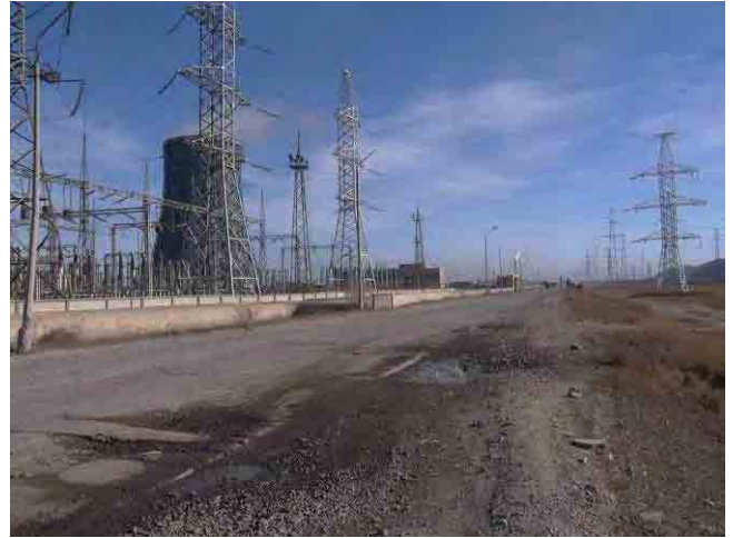
有償要請道路（サブプロジェクト2）発電所の前 （対象道路と発電所の間に温水供給パイプラインが設置されている）
