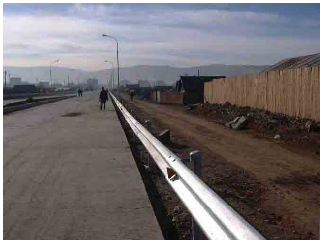
市北部のゲル地区に新たに建設された道路（2）
