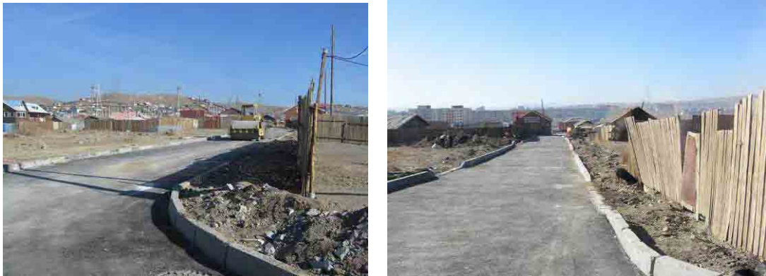
図 2-22 ダリヒ地区 工事現況 (上下水道の地下埋設が完了し、敷地、道路の整地作業が行われている)
