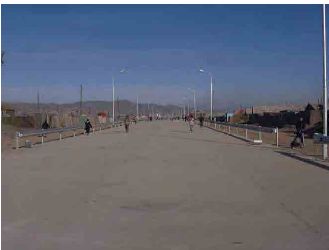
市北部のゲル地区に新たに建設された道路（1）
