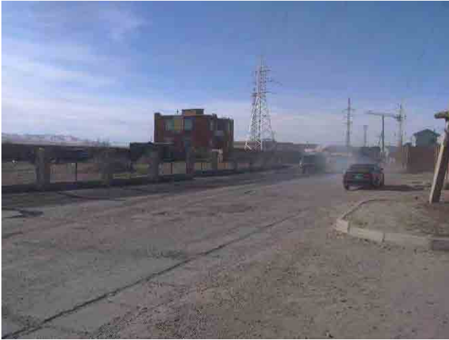
有償要請道路（サブプロジェクト2）東側部分 （大型車両交通量が多く、路面状態が悪い）
