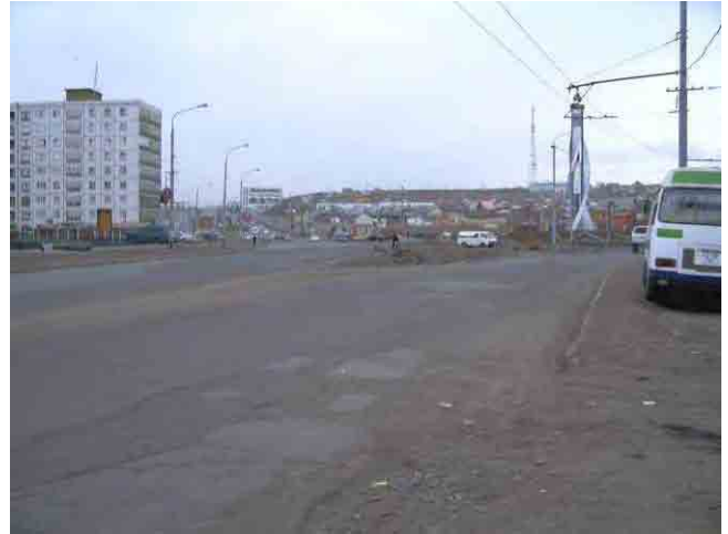
有償要請道路（サブプロジェクト4）北西端交差点 （ラウンドアバウトと信号が設置された変則 交差点である）
