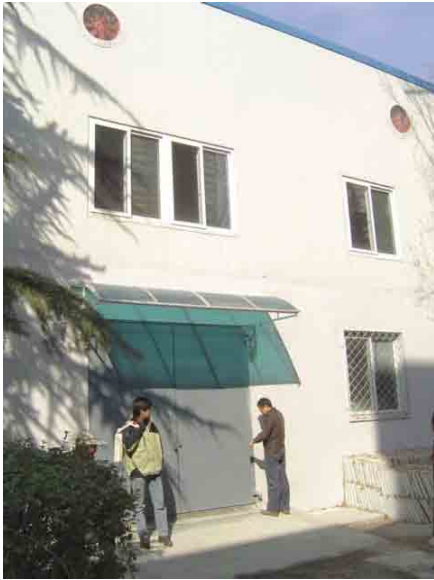
多機能燃焼実験炉設備燃焼炉設置塔
