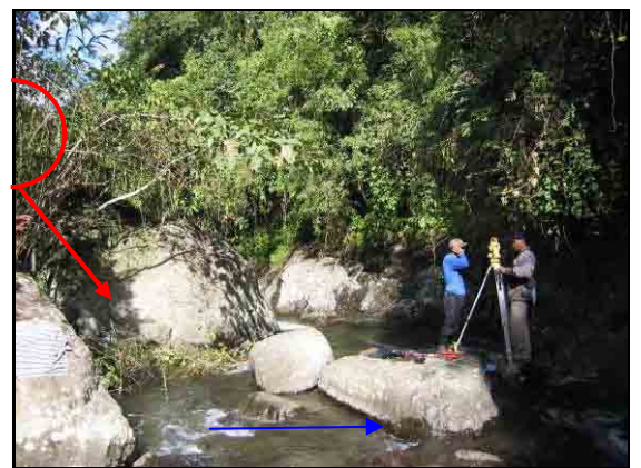
発電所設置場所と放水口
