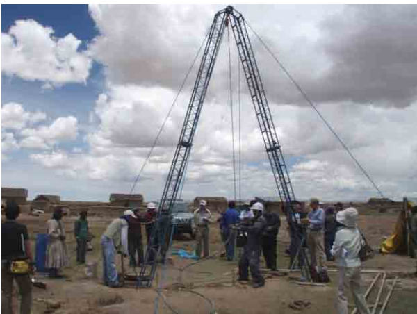
【オルロ県 Tholatia 村の手掘り井戸掘削現場】
