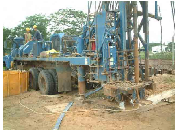
【サンタクルス県 井戸掘削現場】
