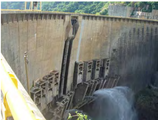
(カボラバッサ水力発電所:アーチダム)
