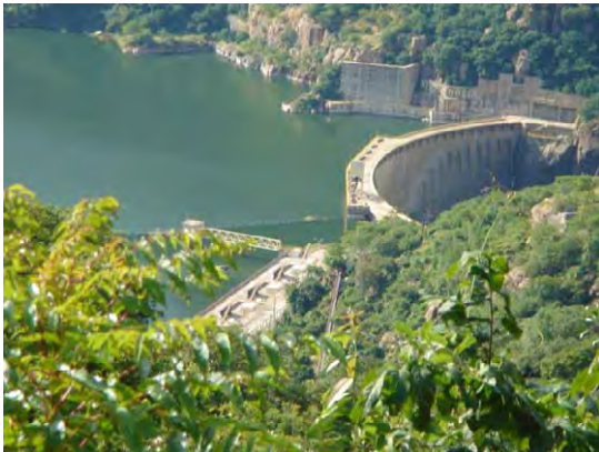
(カボラバッサ水力発電所:ダム全景)
