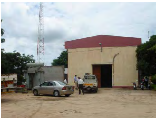
(TeTe 変電所:全景)
