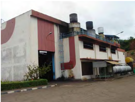
(Ambohimanambola ディーゼル火力発電所: 発電機室建屋)
