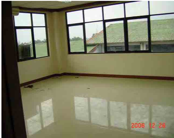
3階(改装中の教室、食堂、寄宿舍)(1)
