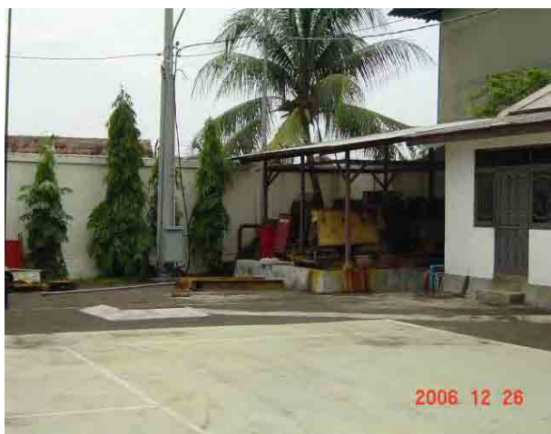
実習室裏(本館裏側)(1)
