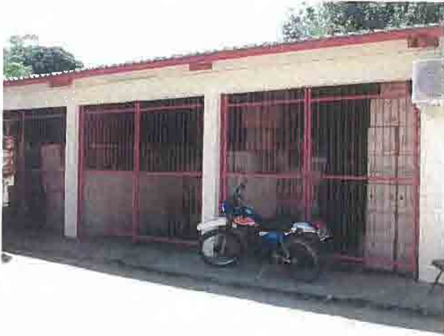
13) イニャンバネ州保健局の倉庫 (本来車庫の予定が、荷が多いことから倉庫として使用)
