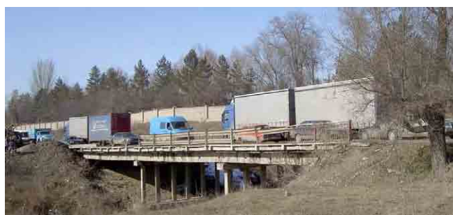
Нынешнее состояние моста Ала-Арча (Мост №2)
