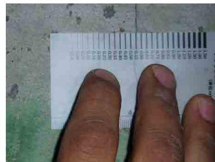
Испытание с помощью шаблона для измерения ширины раскрытия трещин
