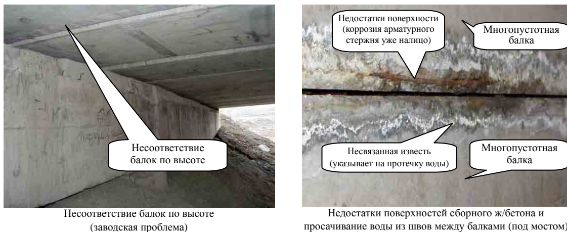
Рис. 2. 2. 1-1 Состояние сборных пролетных балок, произведенных в Кыргызской Республике (мост на дороге Бишкек – Ош)
