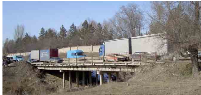
アラアルチャ橋（橋梁番号 No. 2）の現況 （7:00～19:00 の交通量 12,700 台）
