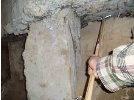
テストハンマーによる検査
