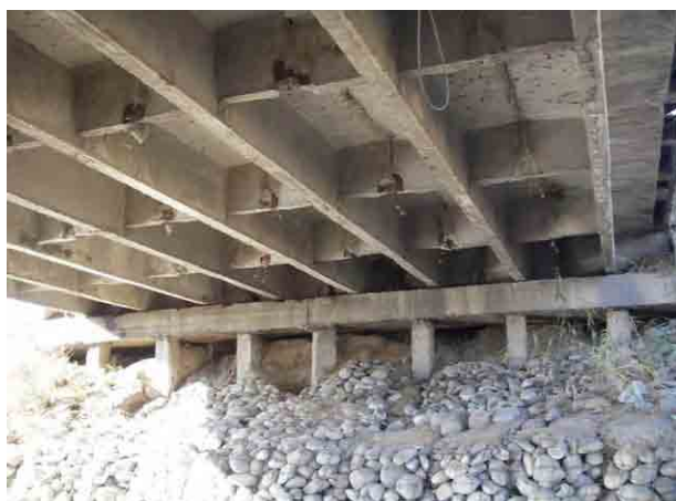
桁及び橋台(左岸) アラメジン橋(橋梁番号No.1)と同様の構造
