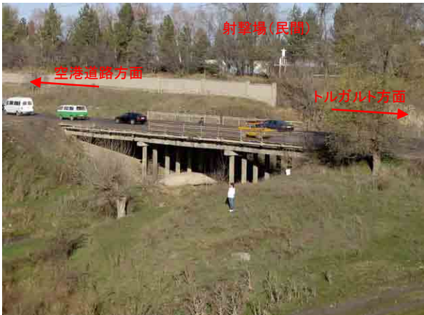
橋梁全景 上流右岸より橋梁を望む
