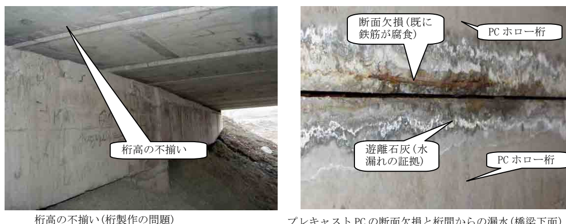
図 3.2.1-1 「キ」国で生産されるプレキャスト桁の状況（ビシュケク～オシュ道路上の橋梁）
