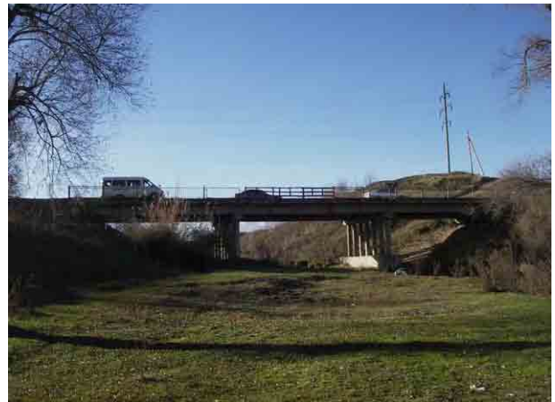
橋梁全景 下流右岸より橋梁を望む
