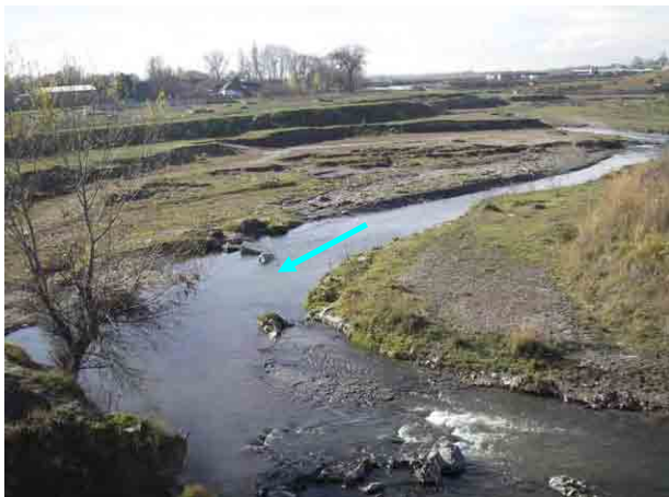
河川状況(上流側を望む)
