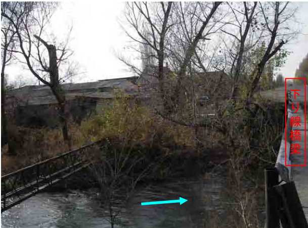
橋梁上流左岸の住宅地
