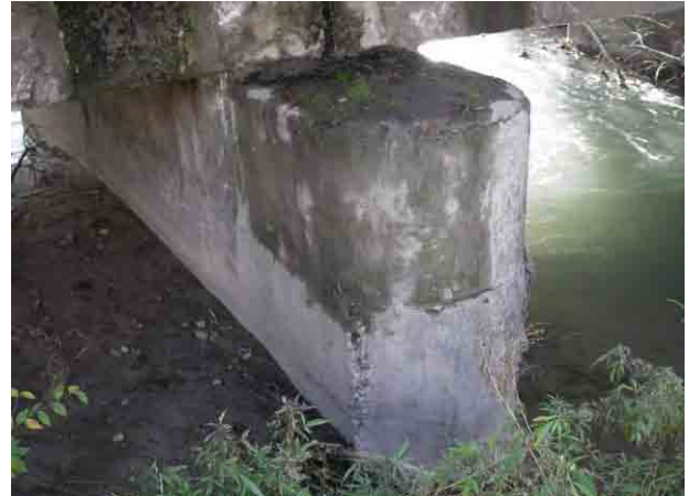
橋脚(下り線橋梁)
