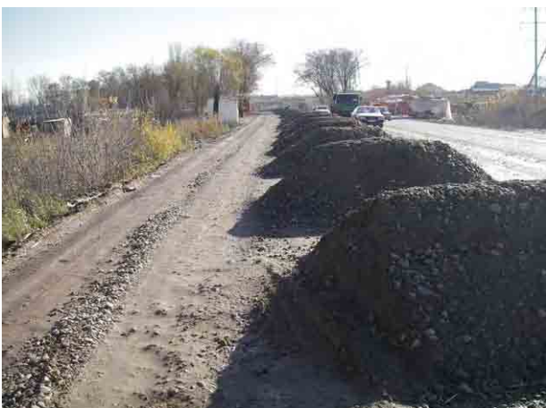
橋梁付近道路の路盤改良工事 MOTC(運輸通信省)により実施 2007年7月完了予定
