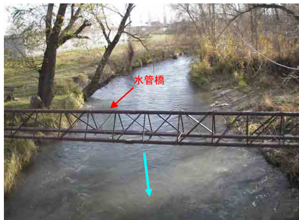
河川状況 上流側を望む
