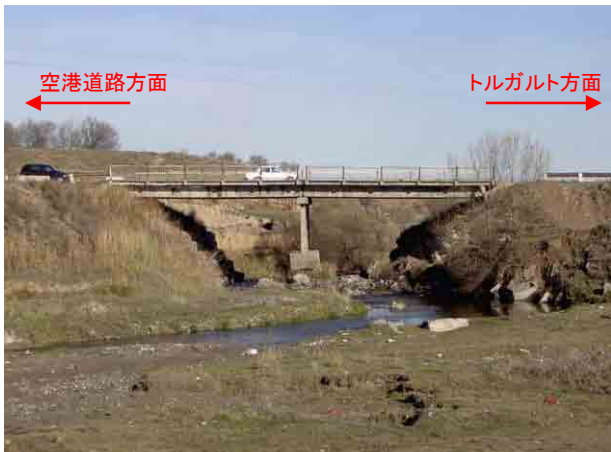
橋梁全景 上流右岸より望む
