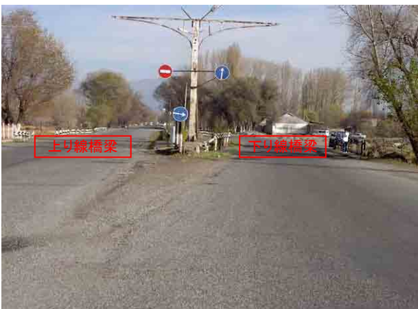
下り線と上り線橋梁の分岐部(トルガルト方面を望む) センターライン等の路面表示がない
