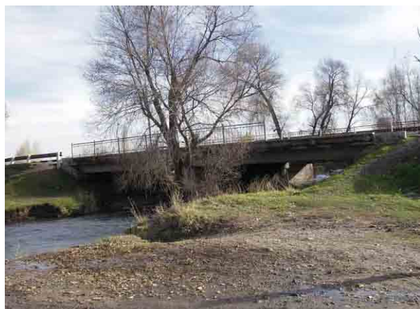
橋梁全景(上り線橋梁:対象外橋梁) 下流左岸より望む
