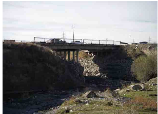
橋梁全景 下流左岸より望む
