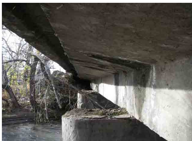
桁(下り線橋梁) 現場打ちRC造
