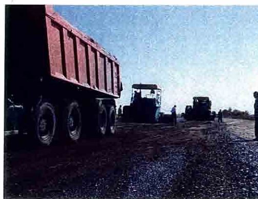
Jizzax-Samarqand道路新設工事
