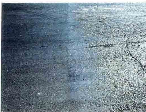
Qurghonteppa – Dusti間舗装状況
