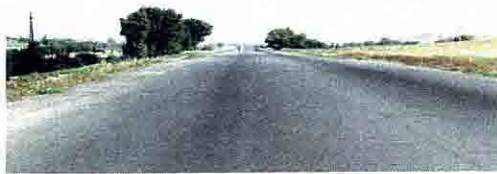
ADB改修区間
