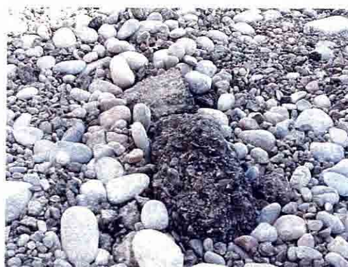
Tashkent-Jizzax間拡幅工事 (粒度調整されていない上層路盤)
