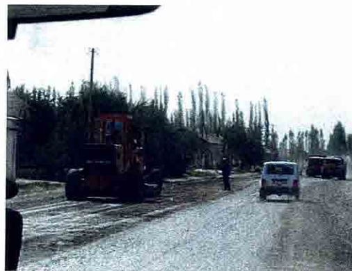
上層路盤 敷設作業
