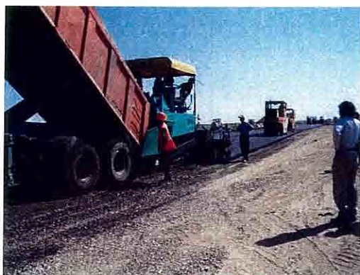
Jizzax-Samarqand道路新設工事
