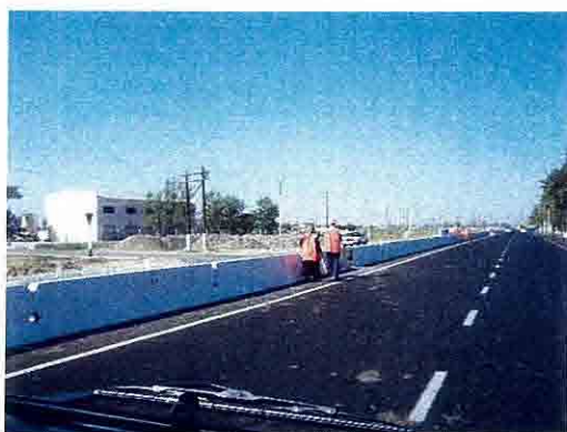
Tashkent-Jizzax (道路公社による清掃)
