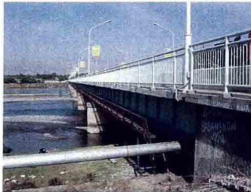
Qizilqala橋(ADBの改修による)
