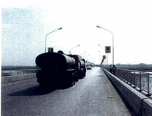
タジキスタン Qizilqala橋ADB改修 (2005. 10. 8)
