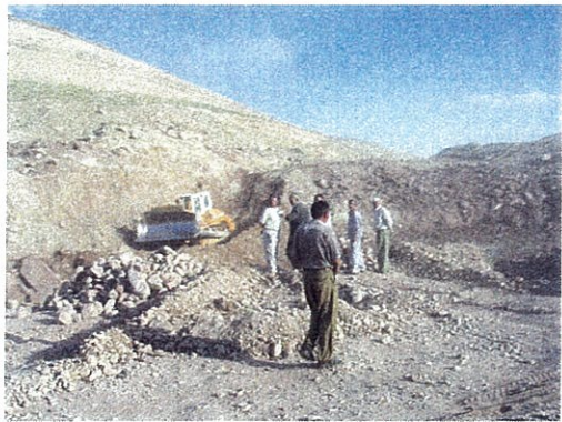
ウズベキスタン バイパス建設現場QARSHI-TERMEZ (2005. 9. 25)
