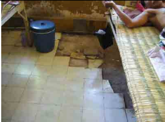
大部分の所でが陥没が見られる1階の床
