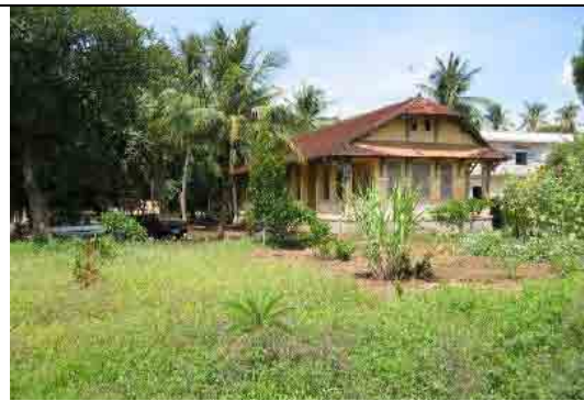
建設予定地にある取り壊し予定の薬局棟
