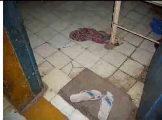
大部分の所でが陥没が見られる1階の床
