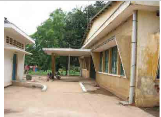
南東側外観(庇で救急部とつながっている)
