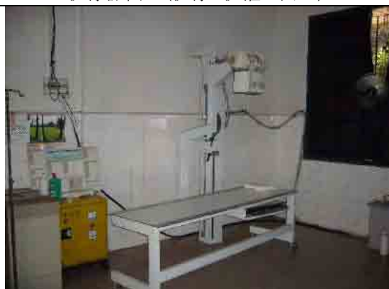
一般撮影室(操作盤は衝立のみで区切られ、窓や扉の放射線防護も無く被曝の危険性がある。)
