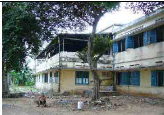
東側外観 2階屋上は簡易屋根の仮設病棟
