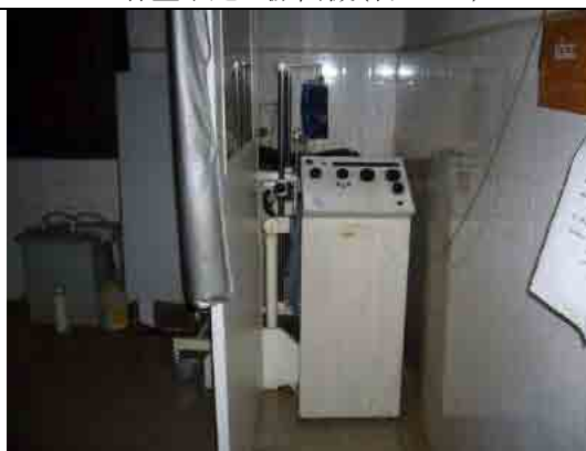
一般撮影室(操作盤は衝立のみで区切られ、窓や扉の放射線防護も無く被曝の危険性がある。)
