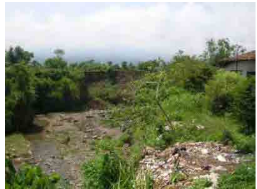
②河岸の崩壊
