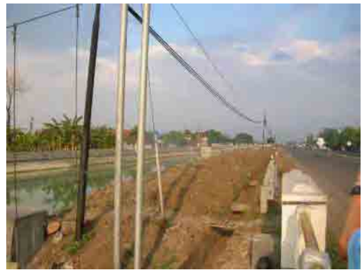
⑥浚渫土砂
