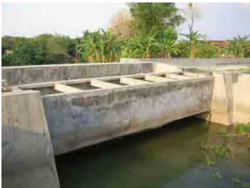
⑤河川改修工事
