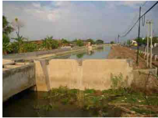
④河川改修工事
