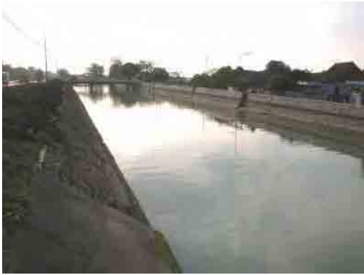
③護岸工が進められている
