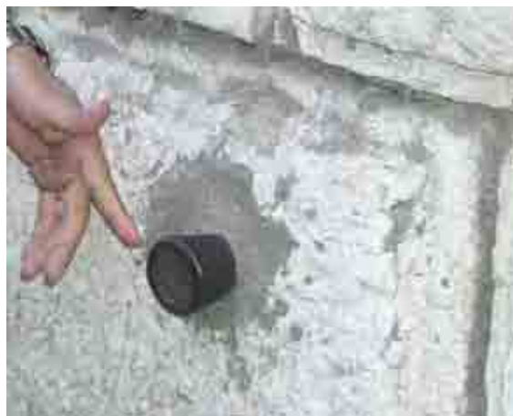
建物の壁に設置された水準点
