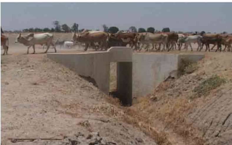
ドドマ州 Mititaa Irrigation Scheme (農民参加型で建設された農道橋)
