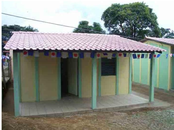
写真ー8 ブロックパネル工法による耐震普及住宅モデル（概観）
