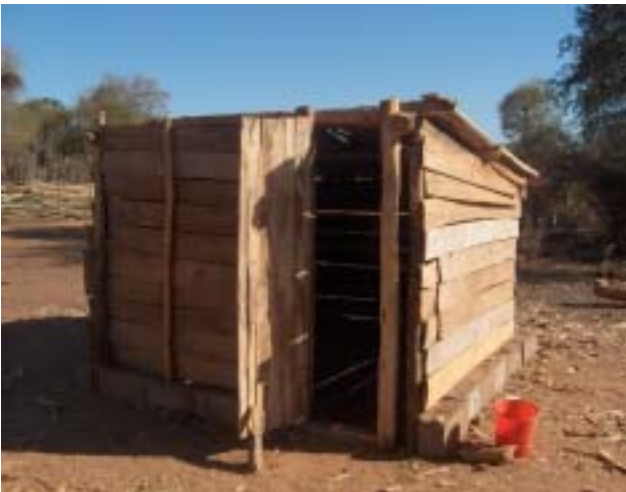
La maison du Technicien Gardien est finie, mais il a démissionné !
