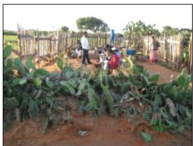
des lourdes tâches attendent, comme la finition des clôtures
