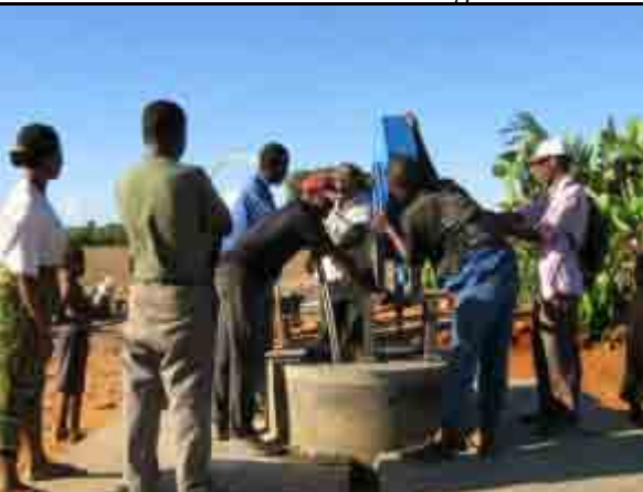
Construction d'un puits à Marobe P009
