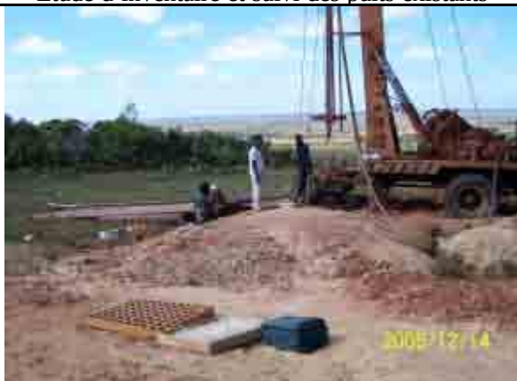
construction d'un forage
