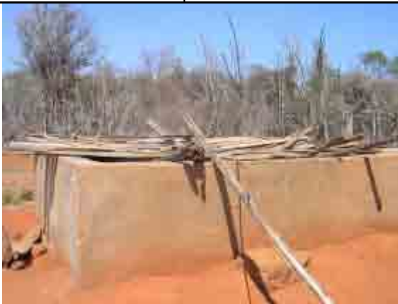
Réservoir dans un village
