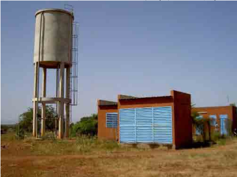
写真-7 Mogtédo 村の公共水栓 ガンズルグ県 Mogtédo 郡 Mogtédo 村の簡易給水施設の給水塔、2003 年に DANIDA が建設、給水人口は 12,000 人、総工費は約 2 億 CFA 程度とのこと。
