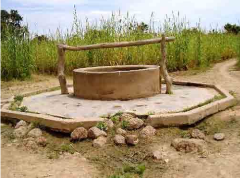
写真-3 Barama 村の浅井戸 クルウェオゴ県 Laye 郡 Barama 村 Bissighin 地区のコンクリートライニングの大口徑浅井戸。地区には浅井戸 2 本しかない。
