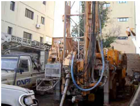
写真-27 1998年無償資金協力の井戸掘削リグ 1998年に無償資金協力で供与された井戸掘削リグ、現 在民営化された会社(SN-ONPF)で使用されている。
