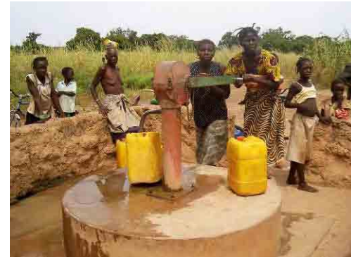
写真-6 Zéguédéghin 村の ABI ハンドポンプ クルウェオゴ県 Toéghin 郡 Zéguédéghin 村 Bissghin 地区の ABI ハンドポンプ付き深井戸。1984 年建設で古いが良いが稼動している。水料金は 3 ヶ月ごとの定額制。
