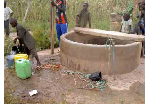
写真-4 Guonsé 村の浅井戸 クルウェオゴ県 Sourgoubila 郡 Guonsé 村 Gouonseblin 地区のコンクリートライニングの大口徑浅井戸。住民の資金で 2004 年に建設。乾季に枯れる。水料金は無料。
