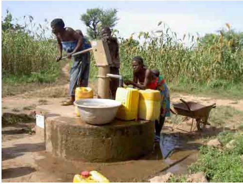
写真-1 Boalin 村の India-Mk II ハンドポンプ ウブリテンガ県 Ziniaré 郡 Boalin 村。21 年前に設置された ABI ポンプをベルギーのプロジェクトで最近リペリを行った。水料金は年 1 回既婚男性 500Fcfa 既婚女性 250Fcfa
