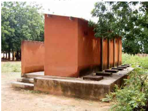
写真-13 日本の無償資金協力による小学校トイレ クルウェオゴ県 Bousé 郡 Bousé 村の Bousé A 小学校のトイレ。日本の無償の第二次小学校建設計画により1998年に建設された。
