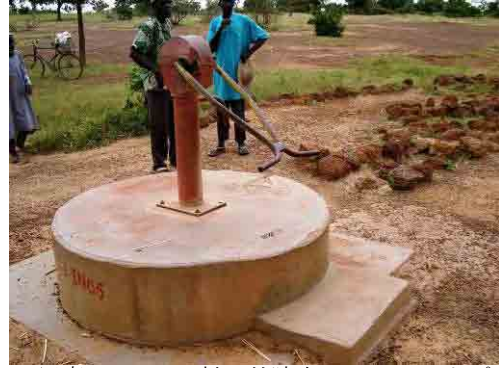
写真-2 Ipala 村の故障中の ABI ハンドポンプ ウブリテンガ県 Ziniaré 郡 Ipala 村。1987 年に建設された ABI ハンドポンプ付き深井戸。約 1 年前から故障中。近年故障が頻繁になり放置されている。
