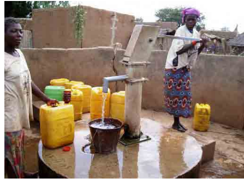
写真-10 Tanwoko 村の India-Mk II ハンドポンプ バゼガ県 Gaongo 郡 Tanwoko 村の India-Mk II ハンドポンプ付き深井戸。村の1200人に1箇所しかない。水料金が10Fcfa/20ℓとハンドポンプとしては最も高い。
