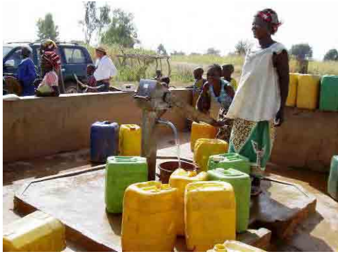
写真-9 日本の1998年無償によるハンドポンプ ガングルグ県 Zam 郡 Kougri 村。日本の無償資金協力により1998年に建設。利用者非常に多く良く使われている。水料金は5Fcfa/20ℓ。ハンドポンプはDIAFA。
