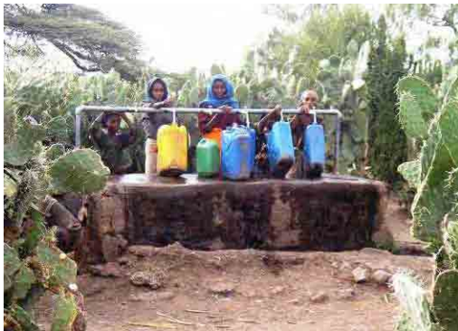
写真-13 Raya Azebo 郡 Genete 村の公共水栓 Raya Azebo 郡 Genete 村の公共水栓。水委員会のメンバー5名の中で現在活動しているのは女性3名のみ。10セント/20~250を現場で料金徴収している。柵はサボテン。
