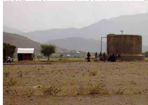
写真-12 Adi Kiros 村の水源地域 揚水ポンプ場と配水タンク(50m 3 )。公共水栓4箇所、Adikiros 村(約9,000人)に給水している。村の水委員会が運営し、口座に38,000ブルの貯金あり。
