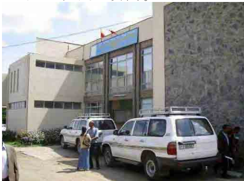
写真-39 ティグライ州水資源・鉱山・エネルギー局本部 本部庁舎で、この他に給水部門、灌漑部門、鉱山・エネルギー部門の事務所建物が別々の場所にある。
