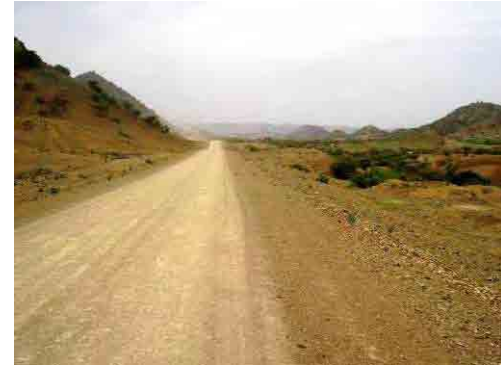
写真-28 Tanqua Abergele 郡の地方幹線道路 ワレダ (郡) を繋ぐ地方幹線道路の多くは、アスファル ト道路ではないが、クレイ舗装で整備されており、穴は 少ない。
