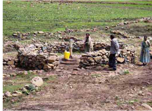
写真-26 Degua Temben 郡 Bille 村のハンドポンプ 人口 360 人。1995 年に REST が建設した Afridev 設置の 深さ 9m の手掘り浅井戸。おそらく粗粒玄武岩中。
