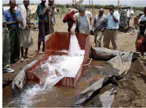
写真-10 沖積層中の深井戸 灌漑用の井戸で、掘削後の揚水試験中。深度198m、ポンプ設置深度58m、口径12インチ、揚水量350/s程度。厚く沖積層が堆積しており、水質の良い地下水が豊富。
