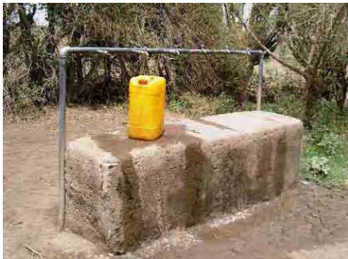
写真-7 Hadelga 村の公共水栓 写真 6 の井戸を水源として、公共水栓 1 箇所と家畜用水 飲み場 1 箇所を給水している。村の水委員会運営。10 セ ント/20~250 を現場で料金徴収している。
