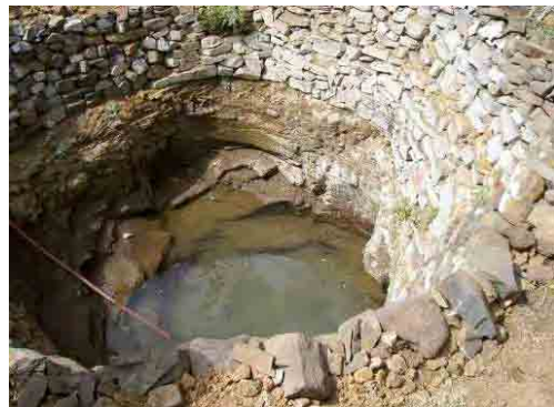
写真-16 Dongolat 村の手掘り浅井戸 灌漑目的で個人が掘った大口径の手掘り浅井戸。井戸深度5m、水位4.5m。帯水層は粗粒玄武岩の表層風化帯。良い水が出たため飲料水として10セント/200で販売している。
