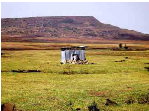
写真-15 Hintalo Wejelat 郡 Dongolat 村の既存深井戸 ディーゼルエンジン駆動のMONOポンプが設置、共同水栓による給水。ドロマイト質石灰質岩中の深井戸で、水質が悪いため使っていない。現在は手掘り浅井戸を使用。
