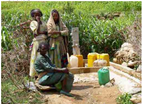
写真-31 Kola Temben 郡 Dabatadoyo 村のハンドポンプ 人口 440 人。2006 年に水資源局が建設した Afridev 設置 の基盤岩中 54m 管井戸。水料金は 0.5 プル/月・戸。他の 村も使うため、追加の井戸を希望。
