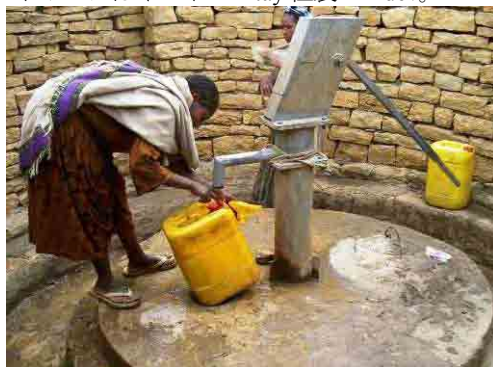
写真-24 稼働中の India Mark II ハンドポンプ
