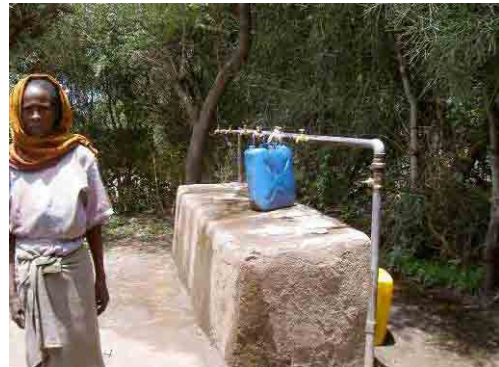
写真-4 Alamata 郡 Gerjele 村の公共水栓 人口 4,100 人の町である。稼動中の深井戸水源の公共水栓 1 箇所ある。追加の深井戸 1 本を要望している。写真の女 性は集金人で公共水栓の鍵を管理している。
