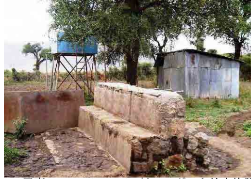
写真-2 Bedena Leko 村のスポット給水施設 1978 年におそらく政府により設置された。深井戸の深 度 90m、静水位 20m 程度、帯水層は沖積層。井戸の孔 壁崩壊が起こり水量激減したため、新規施設を希望。
