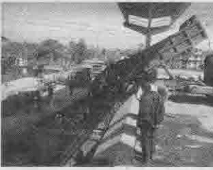
टेकु ट्रान्सफर स्टेशनमा Loading र Unloading अग्यास
