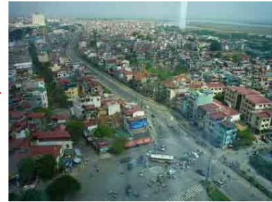
Nút giao giữa đường Thanh Niên và đường đê
