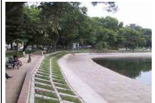
改修後の湖の状況 (2005年7月12日)
