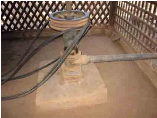
エンジンとモノポンプが老朽化して使えなくなった深井戸 (Chauk Township in Magway)
