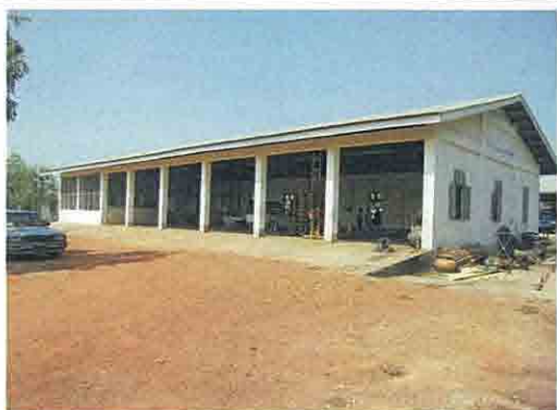
セントラル・ワークショップ棟の全景
