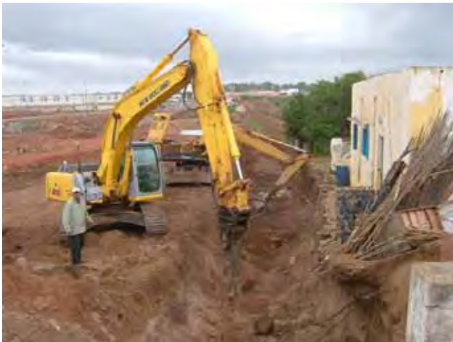
【OUED BOUIBA 水路建設現場】 自己資金で調達した機材を使用
