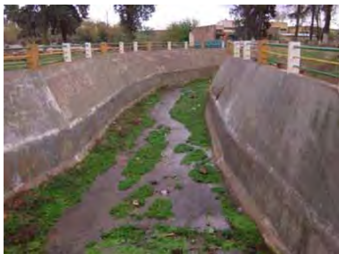
【EL HAJEB 水路】
