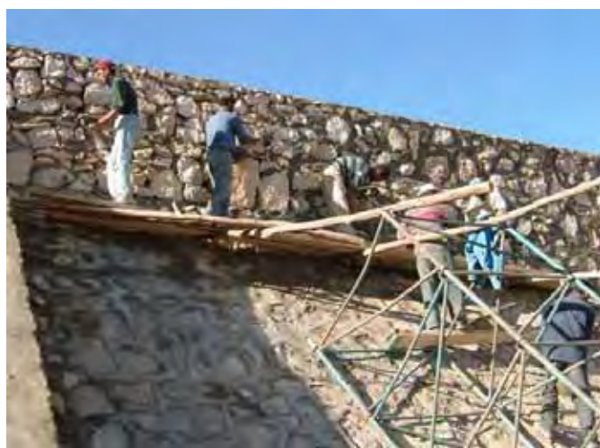
【REYANE ダム建設現場】 地域住民を雇用
