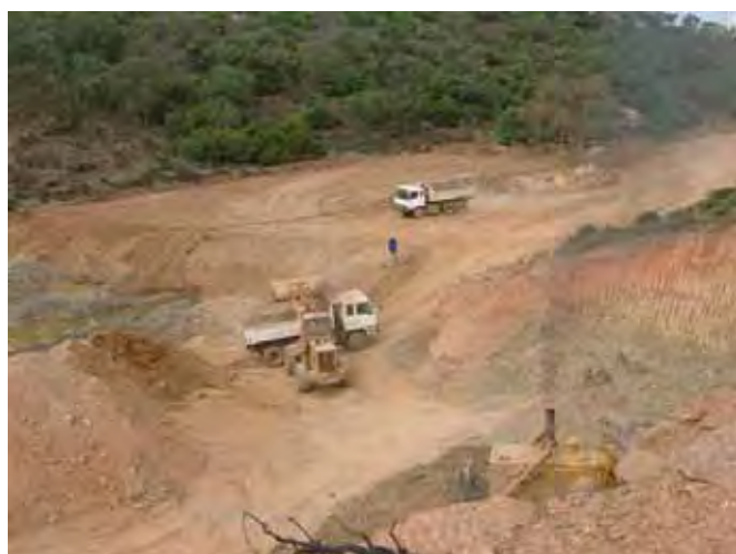
【AIN KAWACHIA ダム建設現場】 日本からの調達機材を使用
