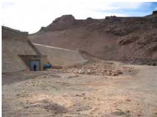
【EL HANDAK ダム】 コンクリートダム
