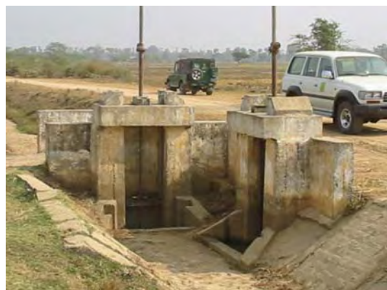
幹線水路堰上水門と支線水路分水門
