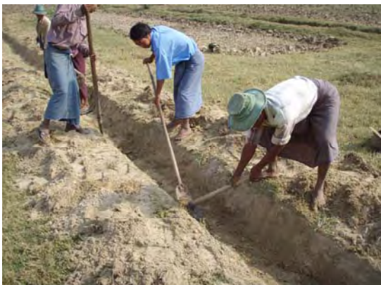
末端水路の建設現場
