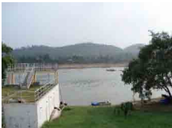
Van Nien 取水場（Houng 川中流部）
