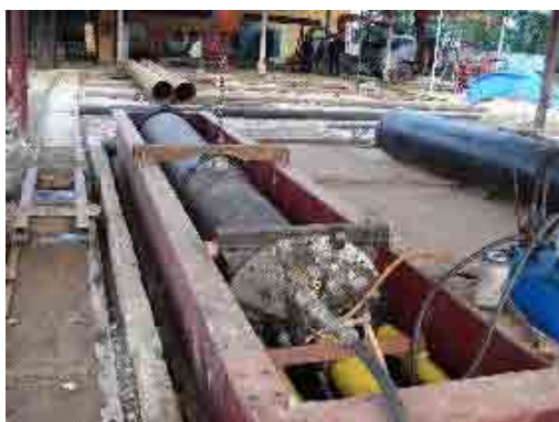
配水管再生現場
