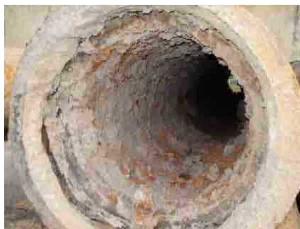
回収済みの配水管
