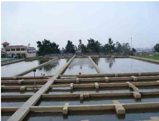
Quang Te 浄水場 ろ過地
