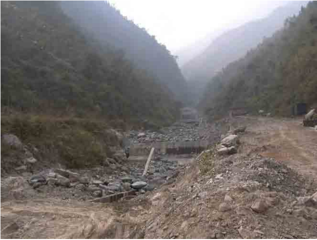
マルシャンディ発電所脇のルワ・コーラ上流を望む。新設のコンクリート砂防ダムが2基あるが、そのすべてが満砂状態にある。
