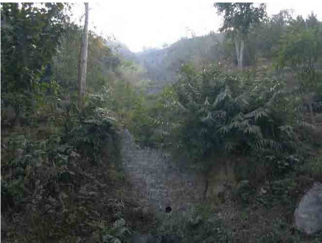
ナラヤンガートから30.9km地点(パイレニ)。練石積の砂防ダムとその上部の階段状床止め、及びバイオエンジニアリングにより砂防効果が良く現れている。
