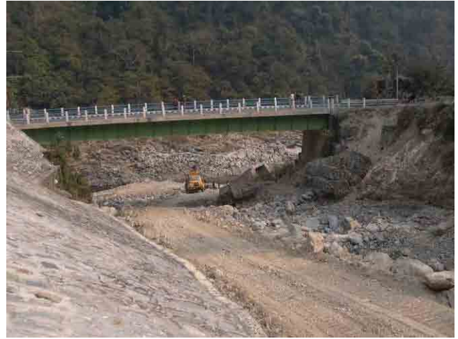
ルワ・コーラ出合の橋梁。2003年の土石流被害で、すべて破壊されている。向かって左側(左岸部)がマルシャンディ発電所。
