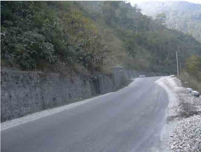
ナラヤングートから 21.7km 地点。左側の山側斜面から右側の谷川にかけて、地すべり地形だと言われている。道路擁壁部に水抜き工が設置されている。
