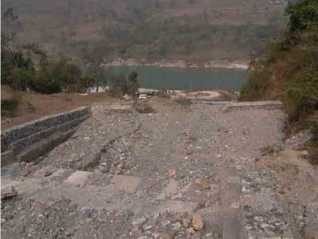
ナラヤンガートから 18.46km 地点。この溪流の崩壊状況はすさまじく、多くのチェックダムがすべて満砂状態にあり、斜面の崩壊も多い。
