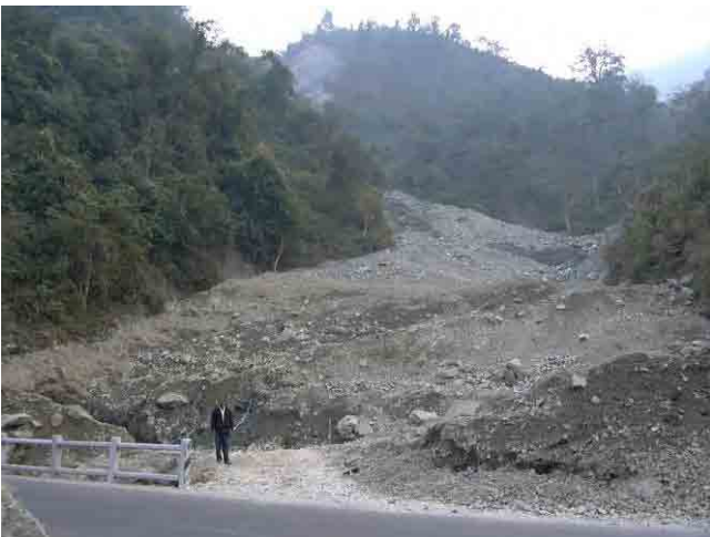
ナラヤングートから 21.56km 地点。土砂堆積厚が 10m 程になっている。チェックダムはほとんど埋め尽されている。道路脇にチェックダムが建設中である。
