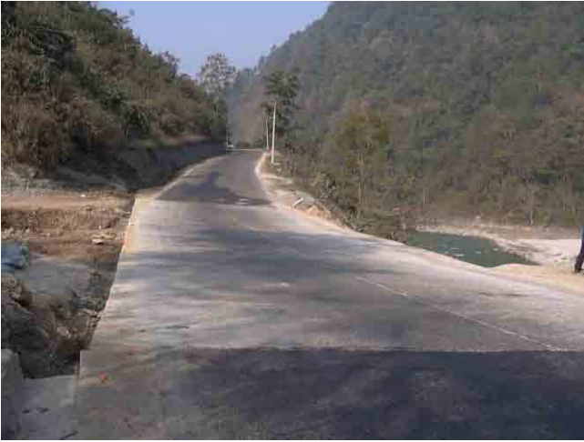
ナラヤングートから 23.76km 地点。土石流堆積物が排土し易いように路面上がコーズウェイ構造となっている。谷側もコンクリート法面となっている。
