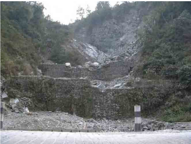
ナラヤンガートから 24.7km 地点。溪流部に多くのチェックダムがあり、すべて土石流により満砂状態となっている。これらは治水砂防局により建設されている。
