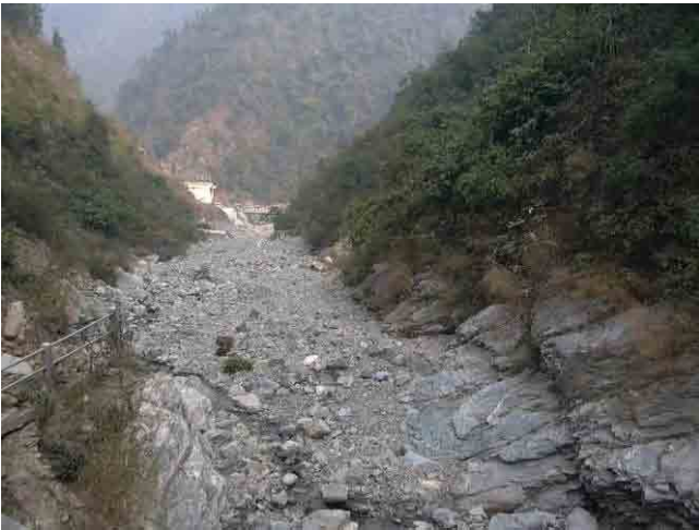
ルワ・コーラ上部砂防ダムから下流側を望む。すでに溪流全体にわたって満砂状態にある。堆砂勾配も限界に近いと思われる。
