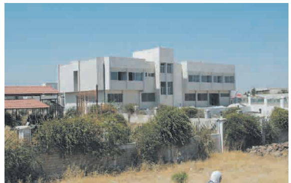
支局前に建設中の新支局ビル
