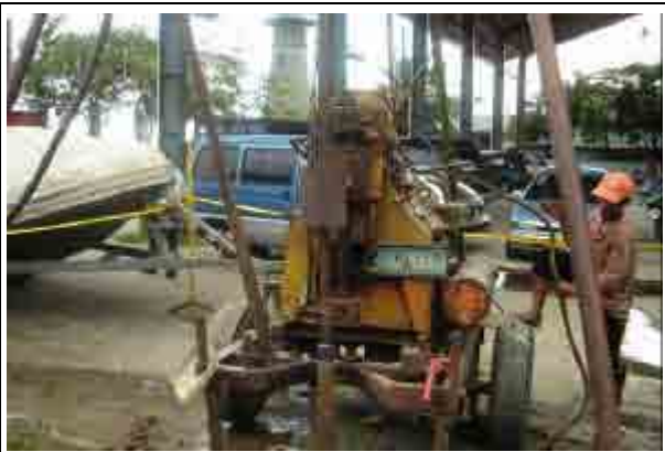
ボーリング調査実施状況 (本 庁)
