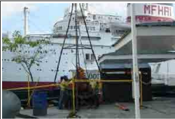
ボーリング調査実施状況 (第一管区本部)
