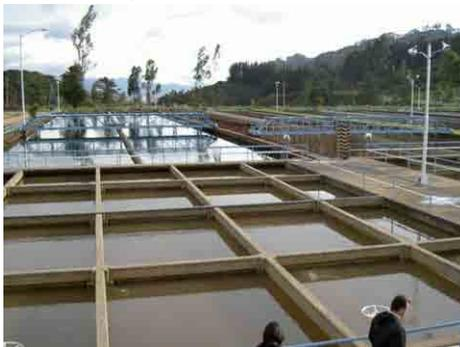
写真-13 ティビトック浄水場の凝集沈殿池
