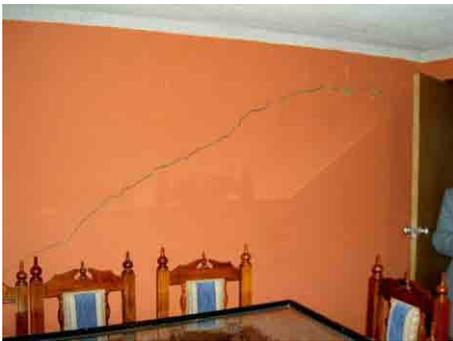
写真-45 地盤沈下の影響とされている壁のひび割れ
