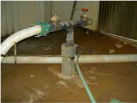
写真-43 ボゴタ平原西部マドリッド市の水道水源井戸
