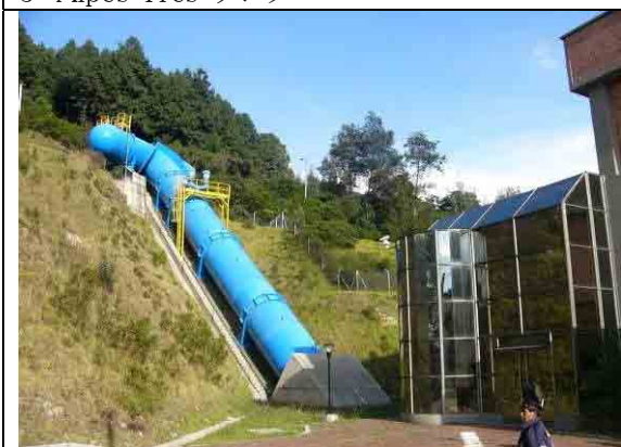
7 Santa Ana 配水場(導水路)
