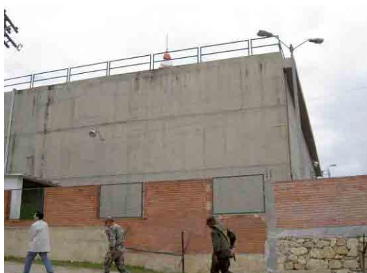
写真-20 配水タンク 写真 19 の水道料金未払い地区に給水しているシエラレキIII 配水タンク。標高 2835m。容量 10,200m 3 。
