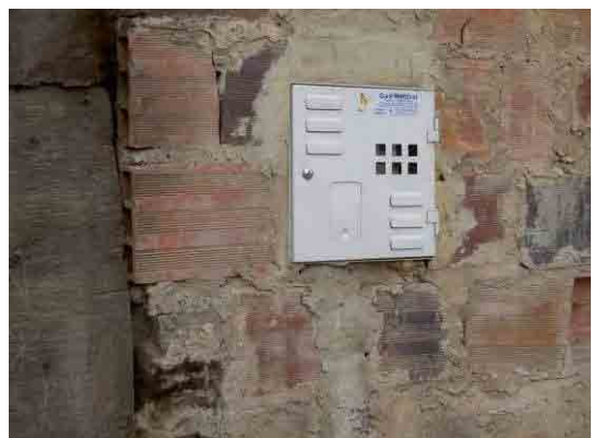
写真-16 ビラロジタの貧困家庭 (ガス) 都市ガスのメーターがある。非合法地区ではあるが、電 気と都市ガスは民間運営のため整備されている。
