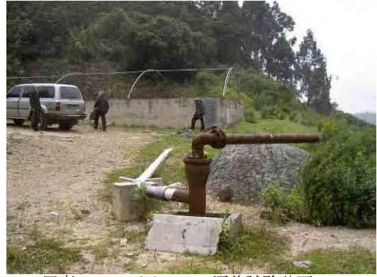
写真-34 ビテルマの涵養試験井戸 ビテルマ浄水場の水源であるサンクリストバル川の取水口付近に ACUEDUCTO が白亜紀砂岩層中に設置した深井戸で、前回開発調査で涵養試験に使用した。
