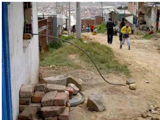
写真-22 アルトスデカスカの不法接続 ほとんどの家に不法接続が行われており、自治会が資金を出して工事を行っているものと推測される。
