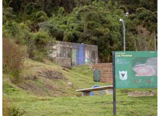
写真-12 ラスビオレタスの配水タンク 自治会により谷川の水を引いて配水タンクに貯め、各戸 給水が行われている。乾期に水無い。料金取っていない。
