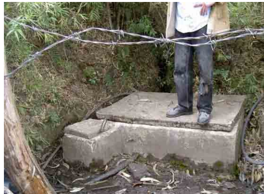
写真-8 アグアスクラーラ(非合法居住区)の水源(約2950m) 自治会が運営している。水源は極く小さな湧水(1.5m 3 /h程度)。未処理。毎月2000ペソ/世帯徴収している。
