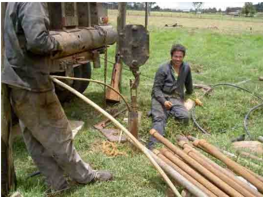
写真-37 ボゴタ平原の井戸 ボゴタ平原部の農家の井戸が揚水量が減ったため井戸掘削会社がメンテナンス中。地盤沈下の影響と見られる井戸の抜け上がりがやや見られる。
