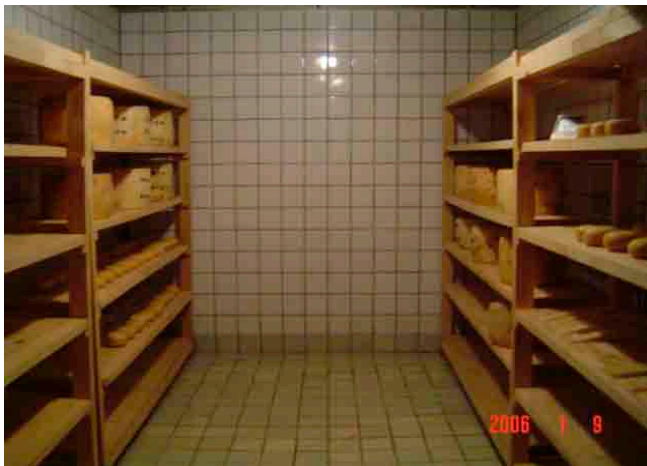
プロジェクトで導入した醗酵室
