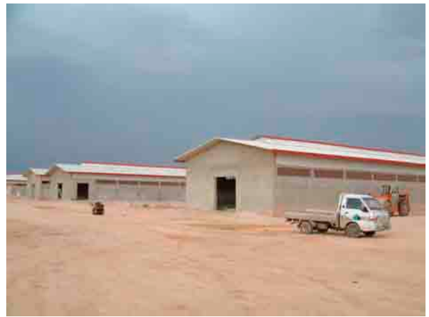
畜舎等建設中の実習農場
