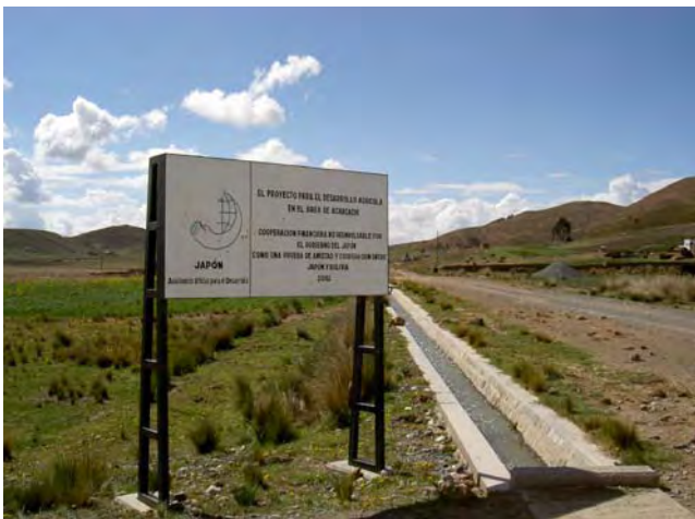
写真9 ラパス県アチャカチ地区、平成12年度一般無償資金協力「アチャカチ地区農業開発計画」で建設された灌漑水路。
