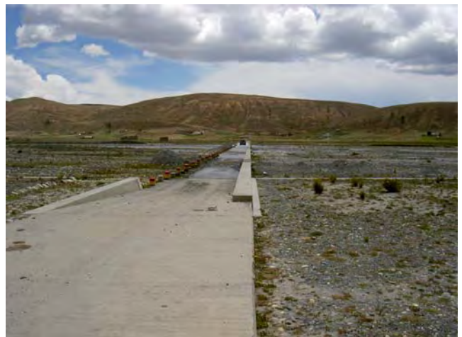
写真10 ラパス県アチャカチ地区、平成12年度一般無償資金協力「アチャカチ地区農業開発計画」で建設された潜水橋。
