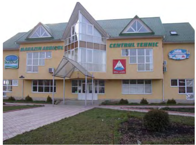
写真-4 <PIU全景> 2KRの実施機関であるProject Implementation Unit(PIU)の事務 所がある建物。モルドバで独自に製作した2KRのロゴの看板が 中央に掲げてある。
