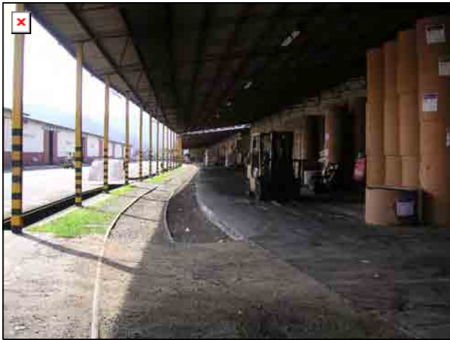
写真9 ALDESA倉庫には鉄道が引き込まれており、2KR肥料は40km離れたコルテス港から鉄道輸送にて倉庫まで運ばれる。同倉庫からBANADESA各支店までは、トラック輸送にて運ばれる。
