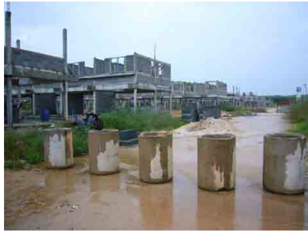
プーケットにおける建設中の NHA 住宅
