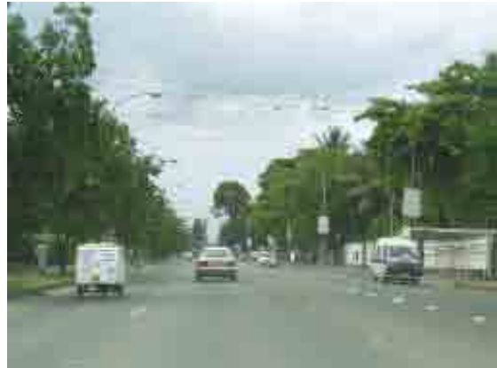
都心に接続する区間は Ali Hassan Mwinyi 道路となる。道路鉾で分離帯が形成されている。
