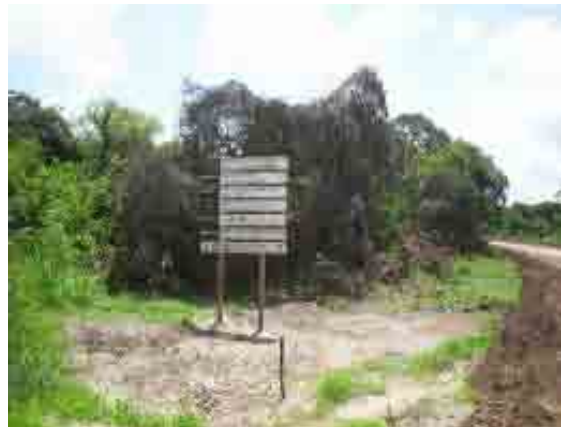
テメケミュニシパリティのキンビジにある道路整備プロジェクトの看板。
