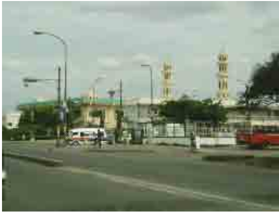
Morogoro 道路と Kawawa 道路の交差点の角にある回教寺院。用地取得が難航し、完全な道路敷き幅員は確保されていない。
