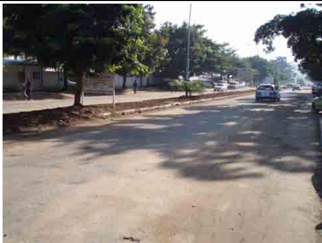
EU が改修予定の道路の状況
