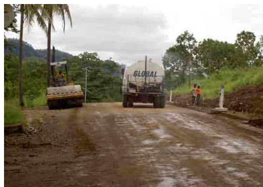
セントラル州のソーリゲ道路（ND 道路）のグレーディングワーク
