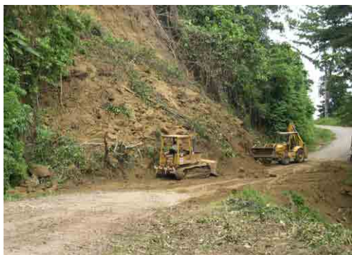
東セピック州のセピック・ハイウェイの斜面崩壊後のデブリ搬出作業
