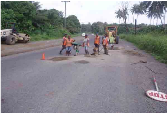
西ニューブリテン州のWB資金によるニューブリテン・ハイウェイのパッチング作業
