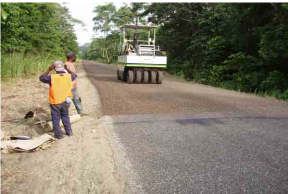
モロベ州ワウ道路のAusAID資金による瀝青安定処理舗装による再舗装
