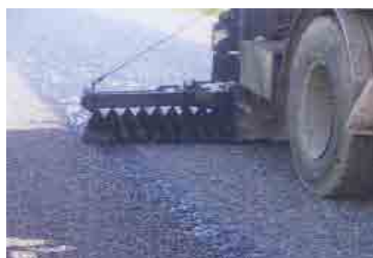
定期維持管理のひとつの瀝青安定処理舗装による再舗装
