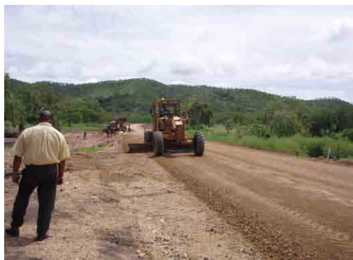
セントラル州のラバラバ道路（NM 道路）のグレーディングワーク
