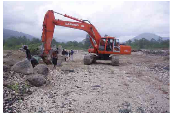
西ニューブリテン州のニューブリテン・ハイウェイのエクスカベータによる土砂の除去
