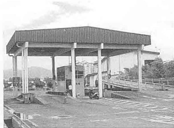
中継所における収集トラックの車載計量所
