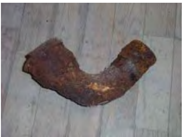
劣化したパイプ
