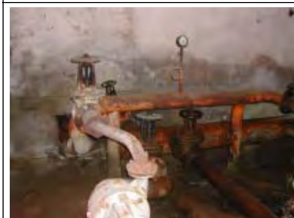
ポンプ場内部
