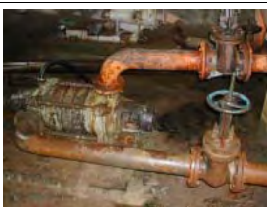
ポンプ場内部
