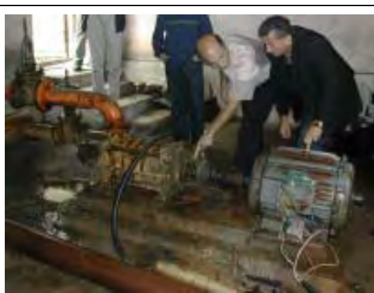
ポンプ場内部
