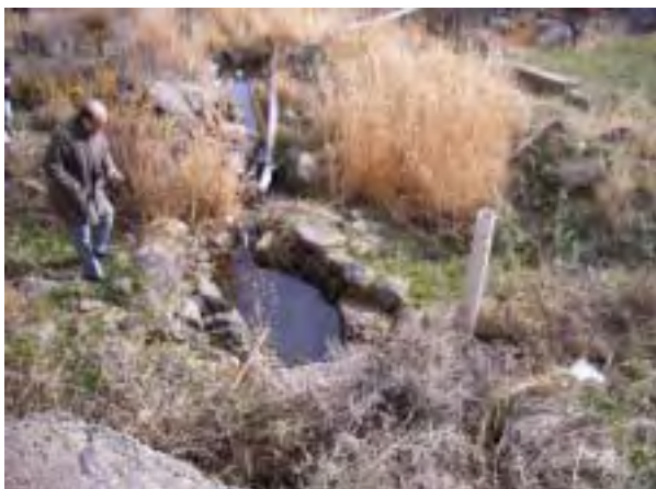
湧水を集めるための取水構造物
