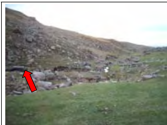
湧水を集めるための取水構造物
