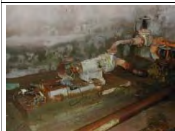
ポンプ場内部
