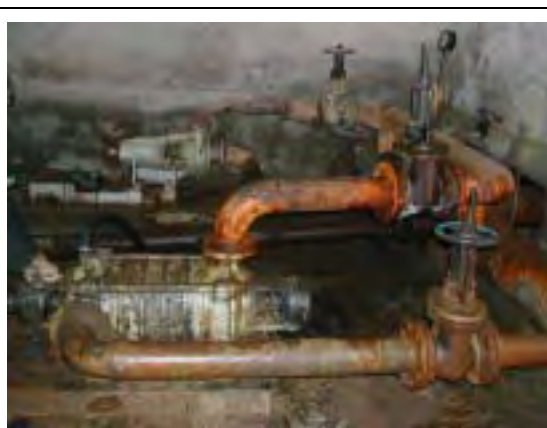
ポンプ場内部
