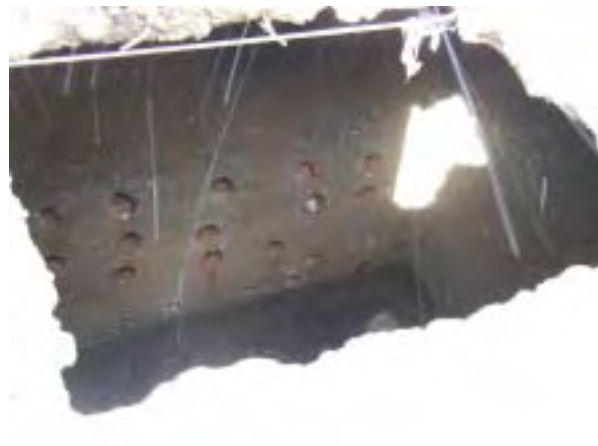
湧水を集めるための取水構造物
