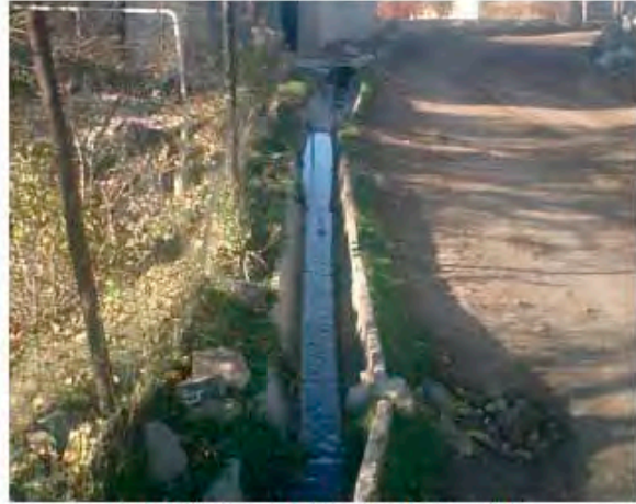
公共水栓からの越流水排水路下流部
