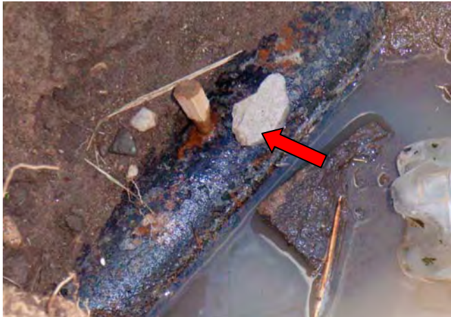
補修のため”くさび”が打たれた管路
