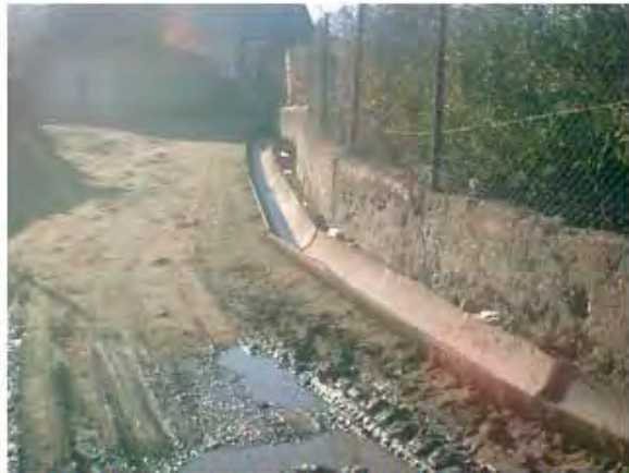
越流排水路下流部 (殆どの排水が目地等から流出、道路に停滞或いは地下浸透している)
