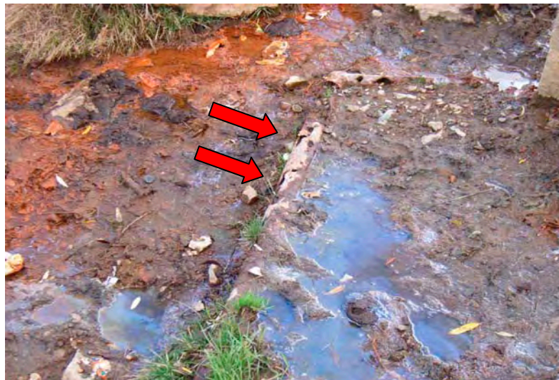
老朽化した管路（鋼管）
