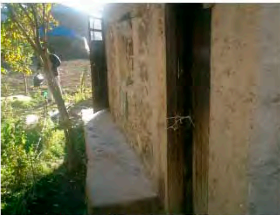
戸外設置の個人用トイレット出入口 (浸透方式)
