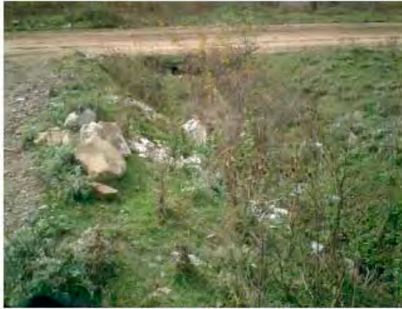
自然排水路(集落近接部)の状況
