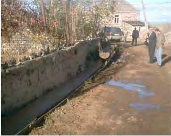
公共水栓付近の排水路 (水栓付近ではU型側溝等で排水している)
