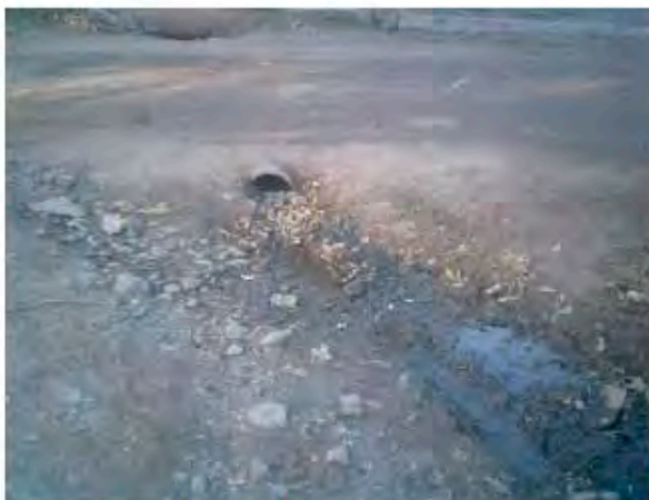
村落内排水路 (道路横断部では廃棄水道鉄管、アスベスト管、コンクリート管などを利用)
