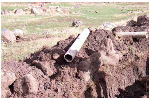
布設替えのため撤去された管路 （アスベスト管）
