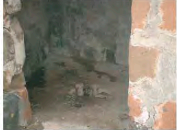
公共トイレット内部の状況
