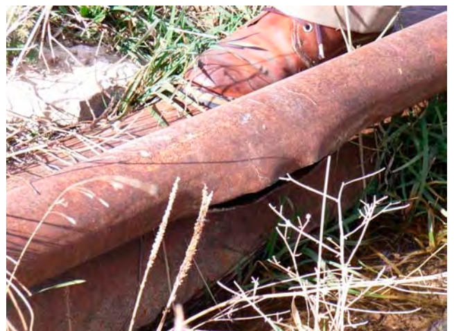
老朽化した管路（鋼管）
