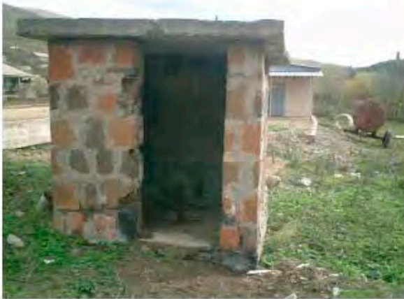
公共トイレット外観 (管路で近接水路へ排除)
