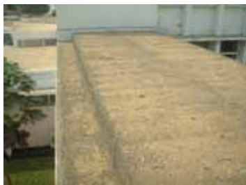
4: A 棟 B 棟間の渡り廊下の屋根
