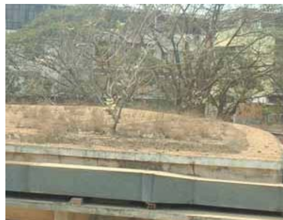
5: D 棟の屋根
