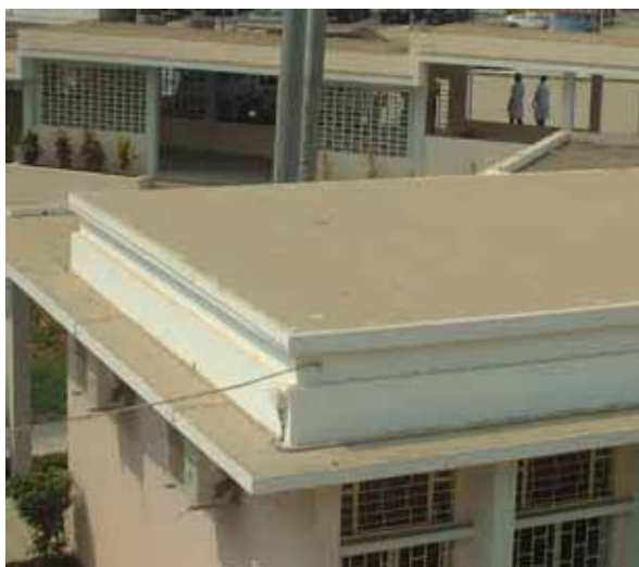
4:C 棟の屋根
