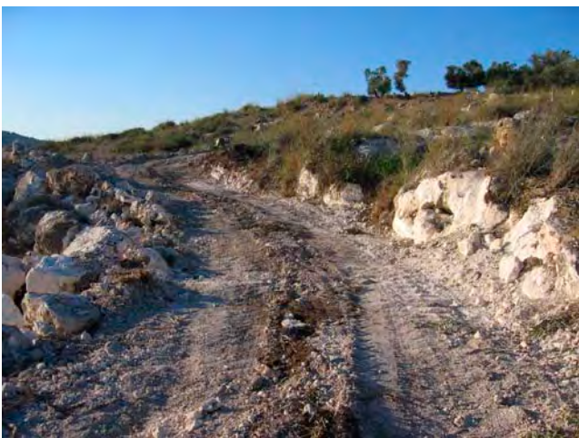
写真11 農業庁が2KRで調達したブルドーザーとエクスカベーターを使用して拡幅した農道。(トウルカレム県アラベ村)
