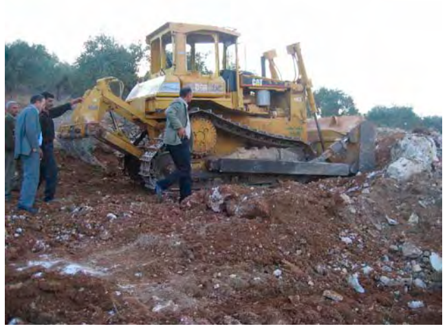
写真8 農業庁が2KRで調達したブルドーザーを使用して農道の拡幅工事を実施しているところ。(カルキリア県ルバン村)
